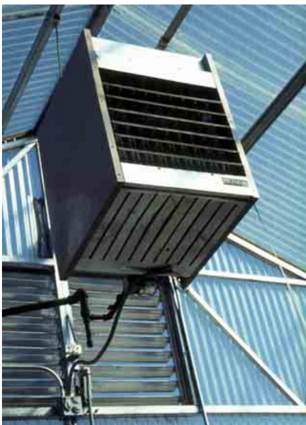
Figura 1.4.2. Las estructuras de propagación pueden ser calentadas con un gran calentador central, el cual distribuye agua caliente o vapor mediante tuberías (A), o con calentadores individuales, los cuales dispersan calor hacia el interior de cada estructura de propagación (B).
