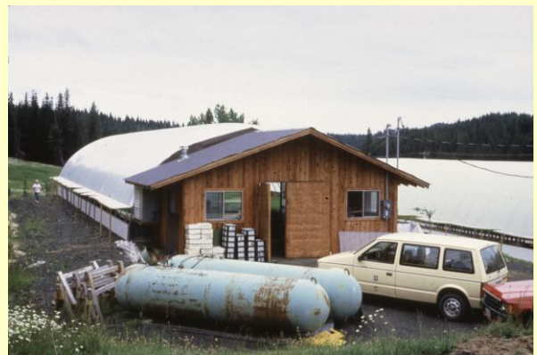
Figura 3.1.23 El gas propano es un combustible popular para el calentamiento de invernaderos en viveros forestales enclavados en áreas remotas.
