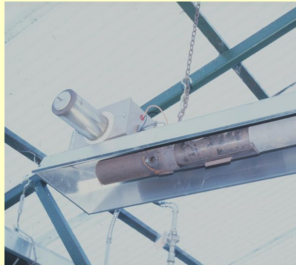
Figura 3.1.28 Los calentadores radiantes en el techo (A) calientan objetos (plántulas y trabajadores) sin aumentar la temperatura del aire de alrededor. El gas es quemado en cámaras de combustión localizadas a lo largo de la tubería de calefacción, la cual está equipada con escudos para reflejar la radiación infrarroja hacia abajo (B).
