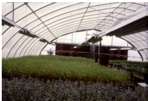
Figura 3.3.29 Las lámparas de halógeno-tungsteno ("cuarzo halógeno") son otro tipo de luz incandescente que es utilizada para el alumbrado fotoperiódico continuo en los viveros que producen en contenedores. Los bulbos, relativamente pequeños y de elevada intensidad, son colocados en reflectores especiales que con frecuencia son montados en un modelo oblicuo fijo.
