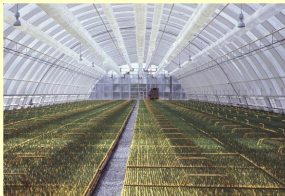
Figura 3.1.16 La ventilación por convección, puede ser aumentada con sistemas de ventilación con tubos, los cuales introducen aire seco y frío dentro del cálido y húmedo techo del invernadero. Cabe señalar que cualquier equipo en el techo puede producir sombras que pueden reducir la fotosíntesis y afectar el crecimiento, si tal sombra es persistente sobre la misma área.
