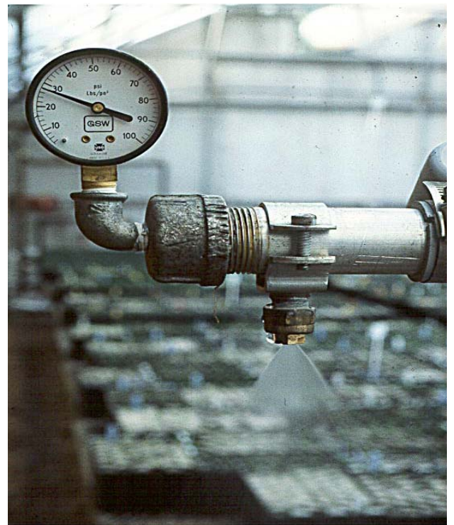
Figura 4.2.23 La presión del agua deberá verificarse regularmente en o cerca de la boquilla de riego.
